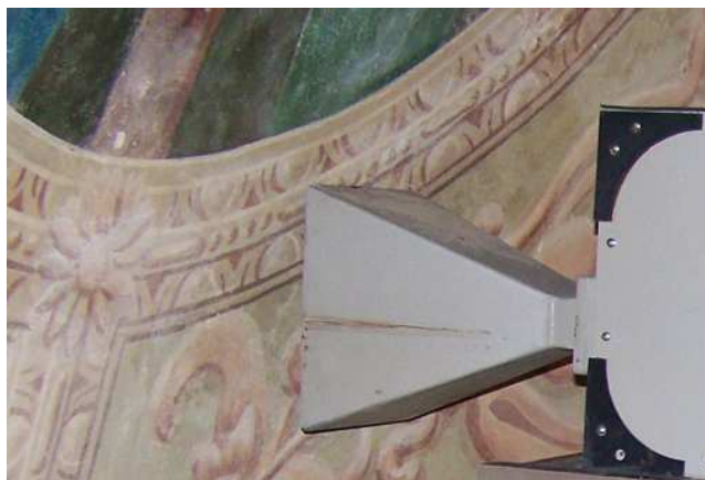
Rysunek 13: Osuszanie kaplicy pod nadzorem konserwatora zabytków przy temperaturze \leq 60^{\circ}\text{C}
